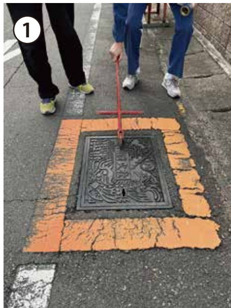
① 消火栓地下式キーハンドルで消火栓蓋を開ける。
