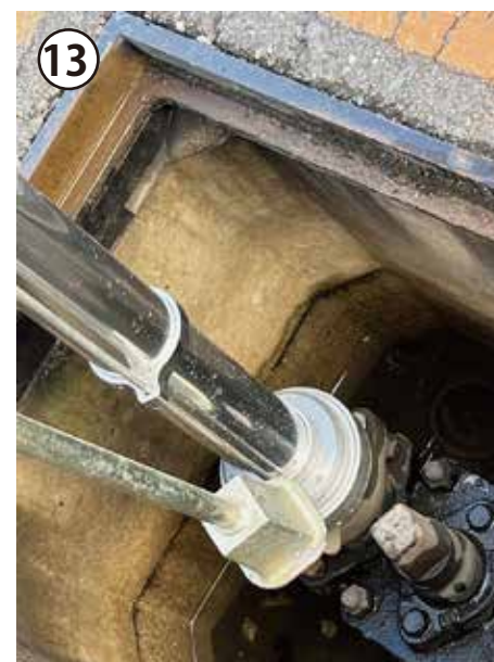
⑬ 消火栓地下式キーハンドルで消火栓のコックを右にゆっくり回して水を出す。
