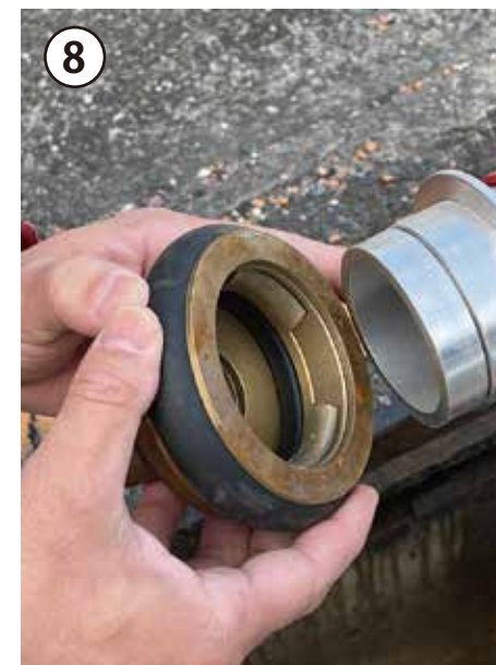
⑧ 40mmホースを取りつけるため、スタンドパイプに媒介金具を取り付ける。
