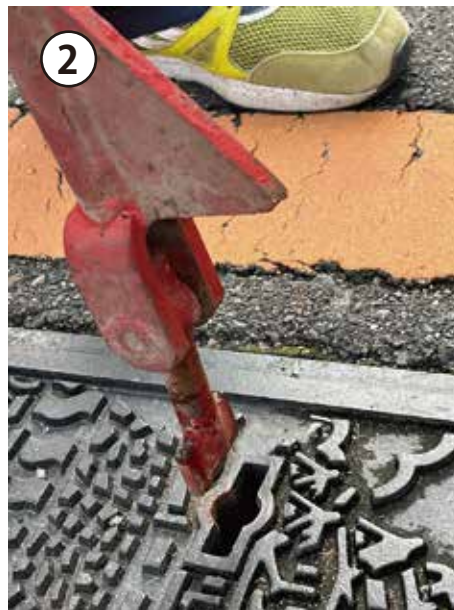
② 蓋の穴にキーハンドルの先を入れ、90度回転させる。
