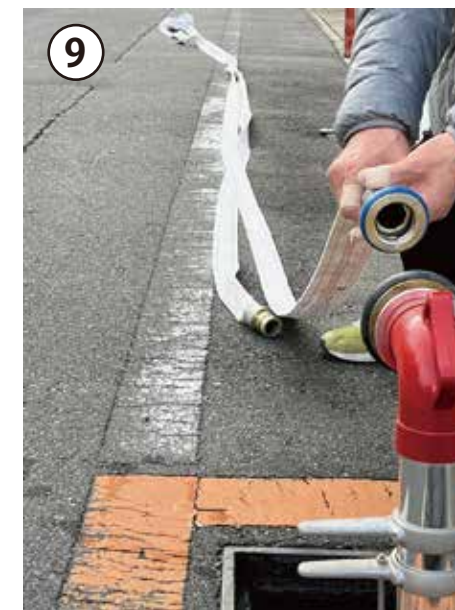
⑨ 40mmホースを伸ばしてからスタンドパイプにホースを取り付ける。
