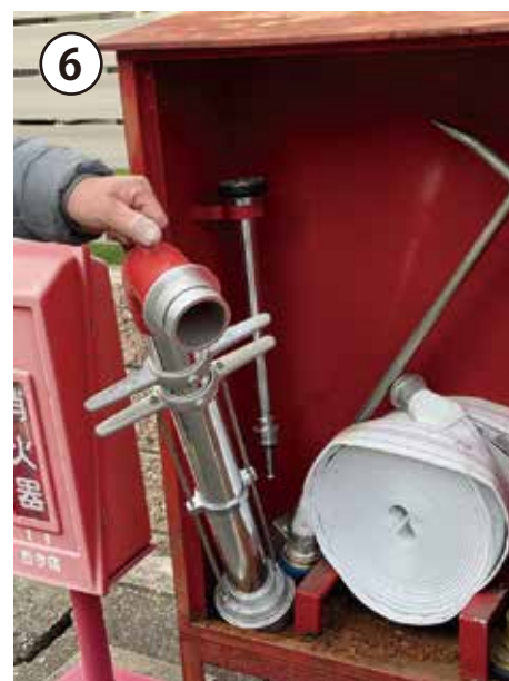
⑥ 消火栓ホース格納箱からスタンドパイプを取り出す。
