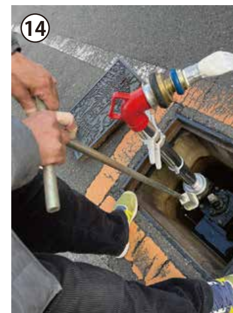
⑬ 消火栓地下式キーハンドルで消火栓のコックを右にゆっくり回して水を出す。
